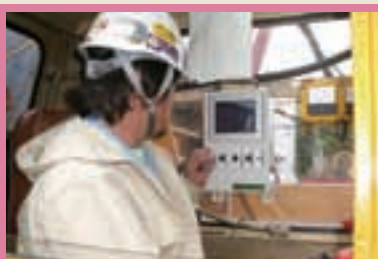
操作盤 (運転席に設置)
