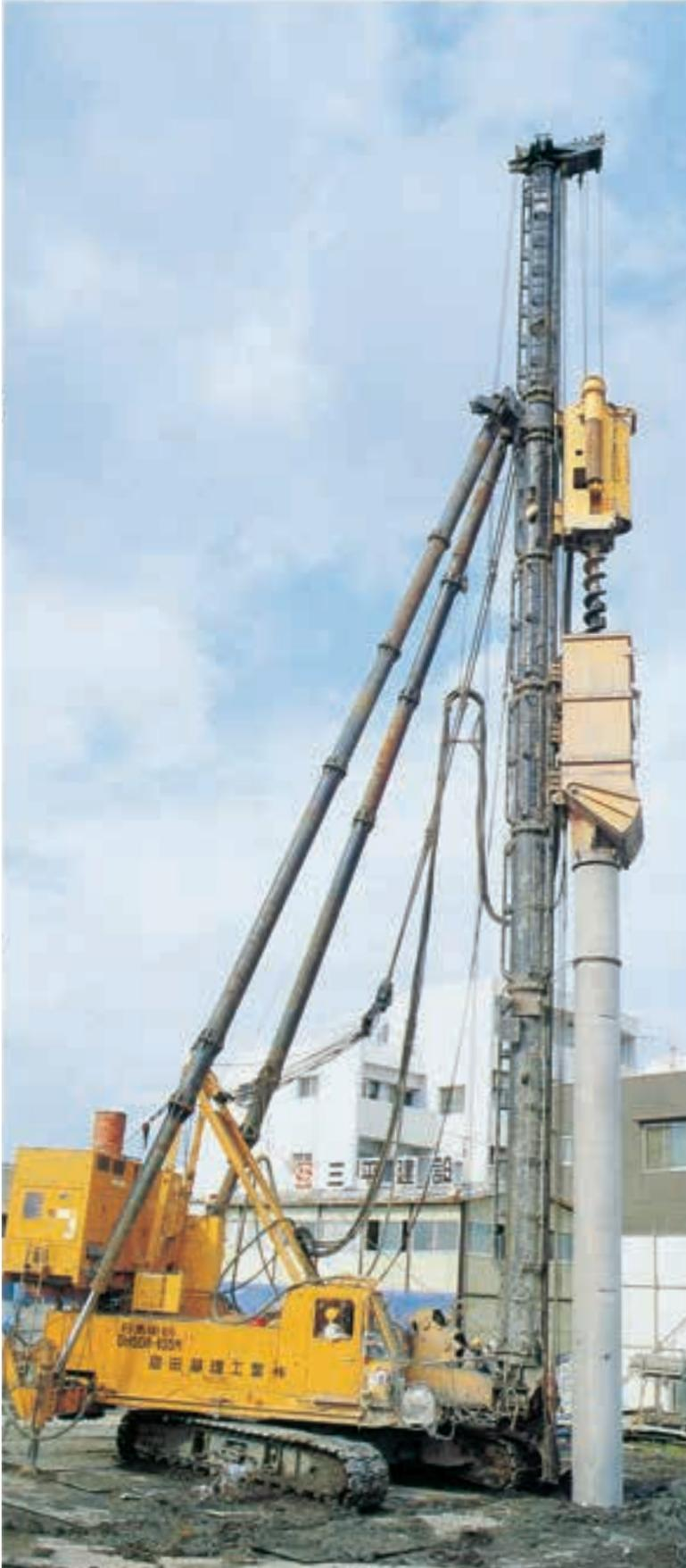
STJ工法は、先端部に高圧噴射ノズルをもつ、STJビットを取付けた連続スパイラルオーガを、あらかじめ杭中空部に挿入して杭を建込み、オーガ駆動装置にスパイラルオーガを連結し、掘削を開始します。杭先端が支持層の所定深さに達した後、拡大球根の築造を行います。STJビットの2方向ノズルより高圧水を噴射し支持層の掘削を行った後、オーガの回転を低速に切換え、根固め液(セメントミルク)を圧力18MPa以上でSTJビットから2方向へ高圧噴射させながら、ゆっくりスパイラルオーガを引き上げ拡大球根を築造します。引続き杭中空部内にもジェット噴射しながら、所定の高さまでスパイラルオーガを引き上げて、杭先端部の球根築造の作業を完了します。その後、杭中空部に注水しながらスパイラルオーガを引き抜き施工を完了します。杭先端部に高圧噴射された根固め液の硬化によって、杭体と球根を一体化させ、杭の支持力を発現させる工法であります。
